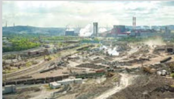
Ежегодное образование металлургических шлаков в ПАО «ММК» составляет примерно 5,5 млн т. Вместе с тем, утилизация образуемых металлургических шлаков достигает 100% за счет таких инициатив, как извлечение и использование в технологическом процессе металлической фракции, реализация потребителям полученного фракционированного и гранулированного шлака и его использование для рекультивации отработанных железорудных карьеров.
