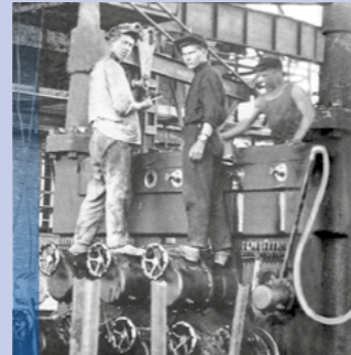
Монтажные работы на стане 500
