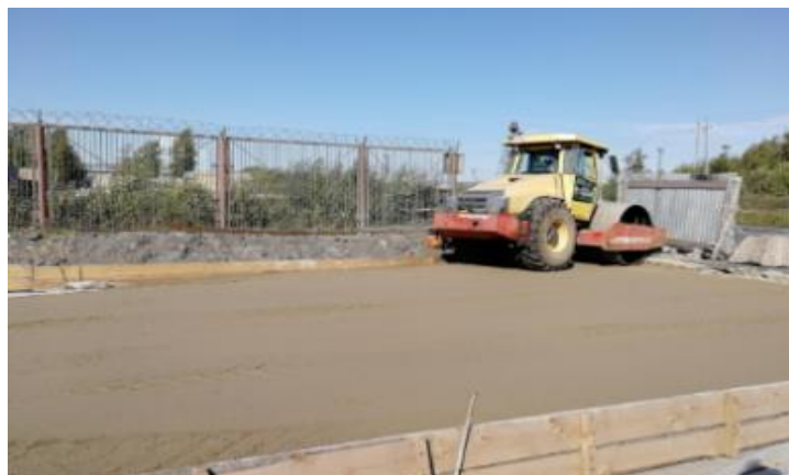
Строительство бетонных дорог с использованием шлака
