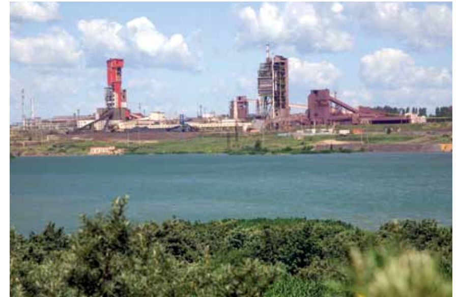
Аккумулирующий отсек Цеха хвостового хозяйства ОАО «Лебединский ГОК»
