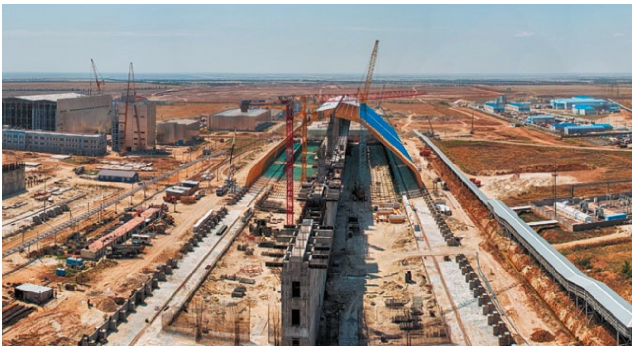
Строительство склада хлористого калия будущего Гремячинского горно-обогатительного комбината в Волгоградской области.
