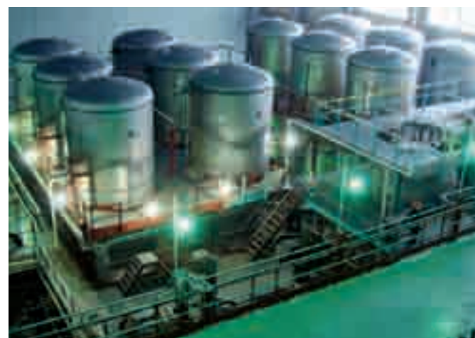
Очистные сооружения на СинТЗ
