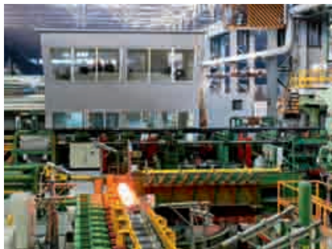
Комплекс по производству бесшовных труб с непрерывным станом PQF на ТАГМЕТе
