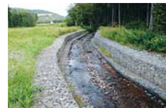
р. Солянка – укрепление габрионами
