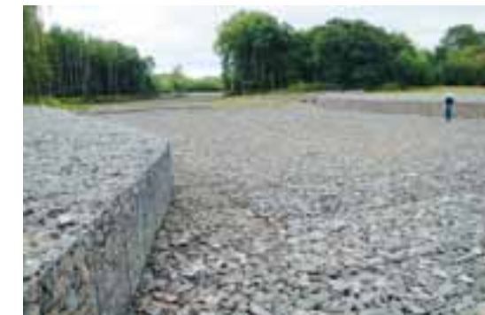
8.3 Техническое обслуживание полосы отвода наземных трубопроводов
