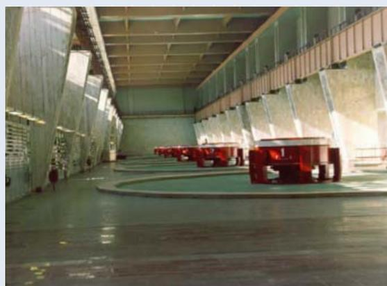
Благодаря специфической технологии Загорская ГАЭС выполняет функции двойного регулирования мощности – в генераторном и нагрузочном режимах. Это позволяет использовать Загорскую ГАЭС для решения большого диапазона режимных задач, связанных с потребностями в регулировании:
