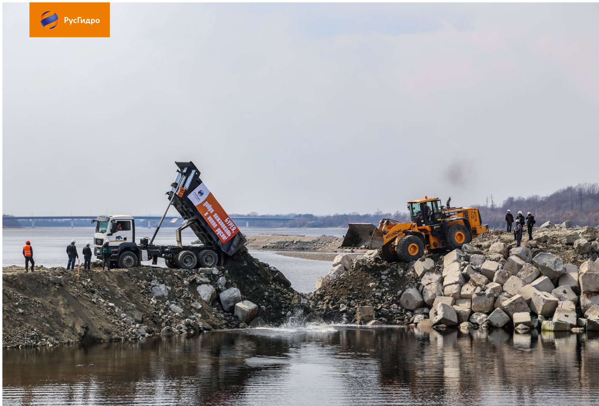
Перекрыта река Буряя на строительстве Нижне-Бурейской ГЭС
