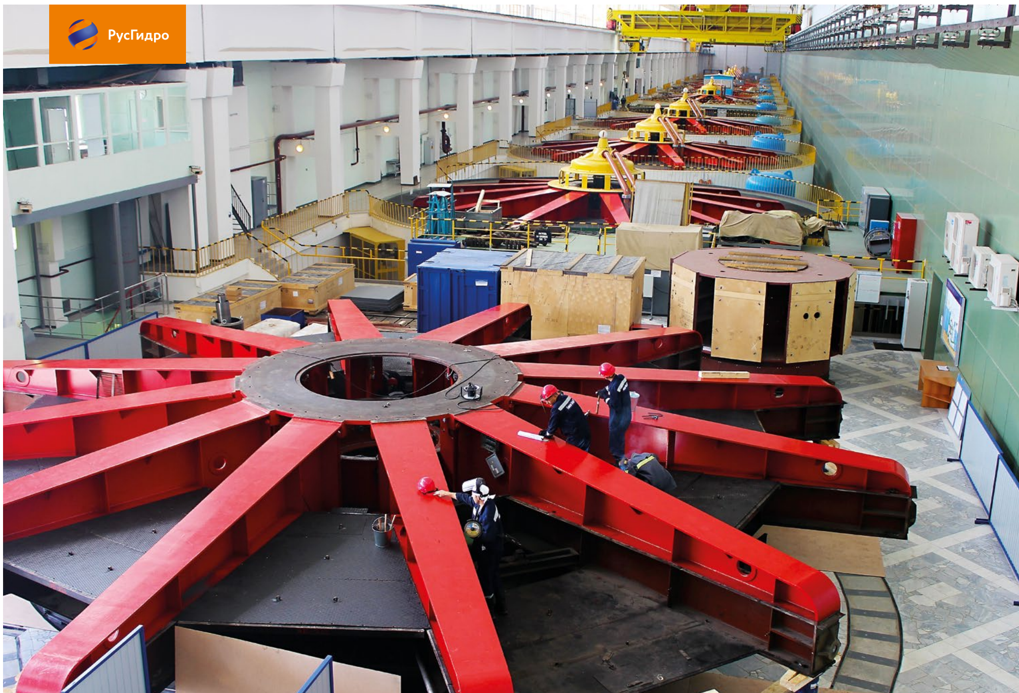
Началась замена гидросилового оборудования Воткинской ГЭС
