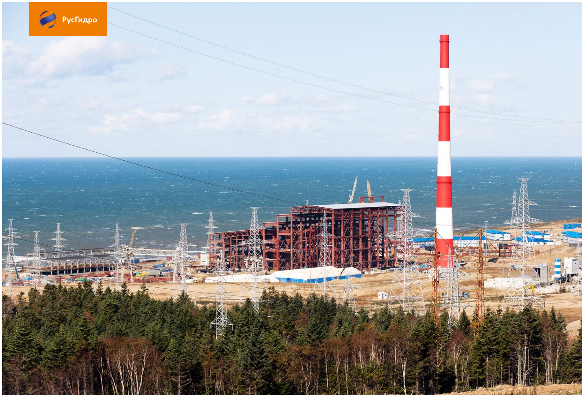
Возведен каркас главного корпуса Сахалинской ГРЭС 2
