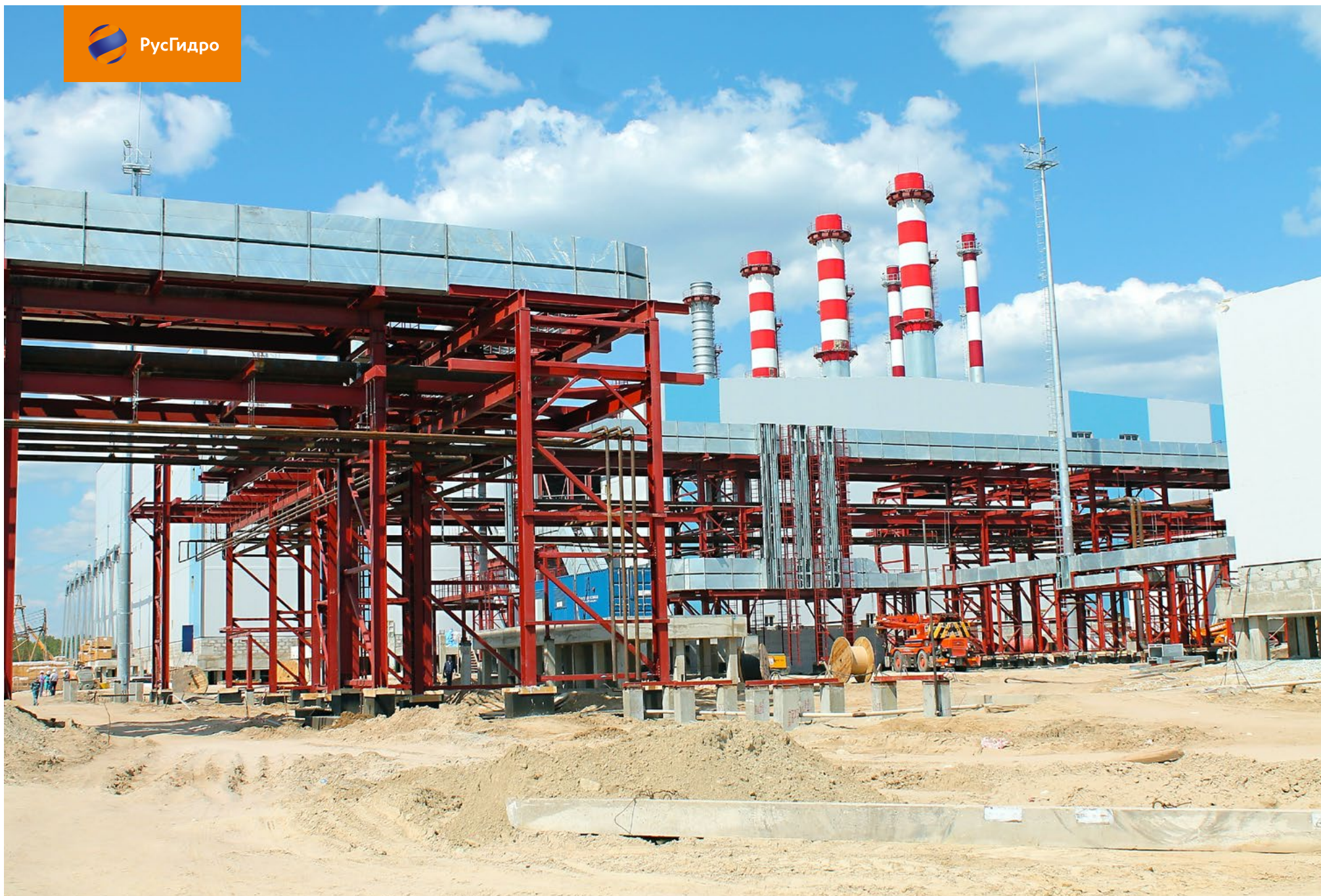
Проведены гидравлические испытания котлов-утилизаторов Якутской ГРЭС-2
