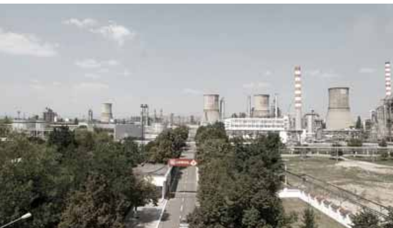
ЛУКОЙЛ ввел в эксплуатацию турбогенератор и единую операторскую на НПЗ в Румынии
