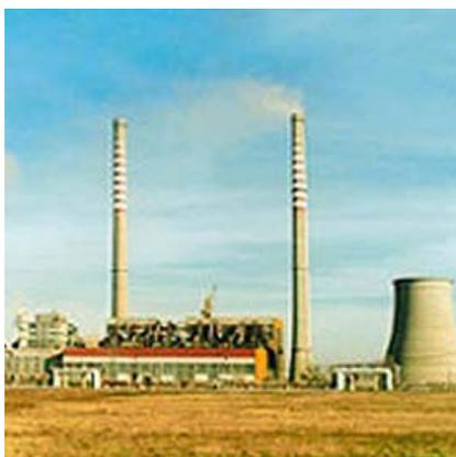
**ТЭЦ "Топлофикация Русе"** (г. Русе, Болгария) расположена на берегу Дуная, в непосредственной близости к гавани Русе. Установленная общая мощность генераторов ТЭЦ – 400 МВт. Общая тепловая мощность – 35 Гкал/ч.
