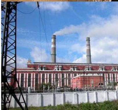
**Открытое акционерное общество «Южно-Кузбасская ГРЭС»** (г. Калтан, Кемеровской области) на 31 декабря 2008 года имеет установленную электрическую мощность – 554 МВт, ее тепловая мощность – 1500 Гкал/ч. Конкурентным преимуществом электростанции является близкое расположение
