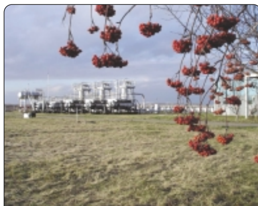
На площадке газораспределительной станции ООО «Кавказтрансгаз»
