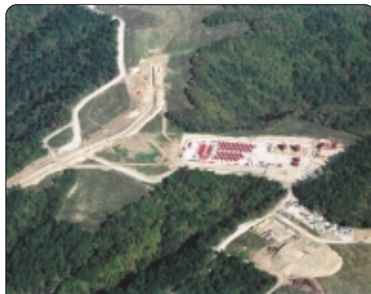
КС «Береговая» газопровода Россия-Турция (ООО «Кубаньгазпром»)
