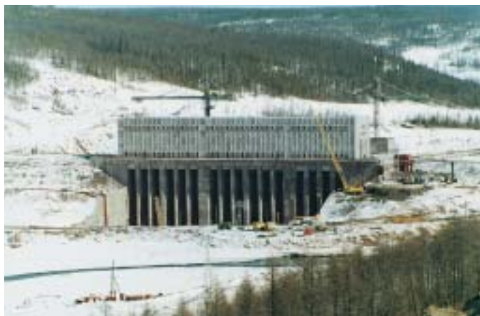
Алмазная компания возводит Вилуйскую ГЭС-3
