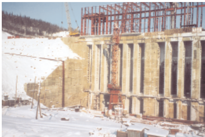
Сооружения Светлинской ГЭС-III
