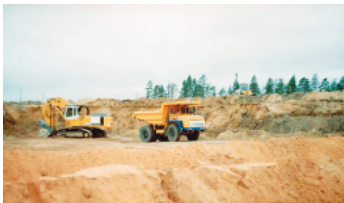
Вскрышные работы на Архангельском месторождении
