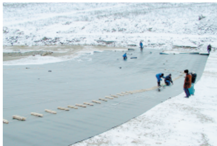
Укладка геомембраны на Накыне
