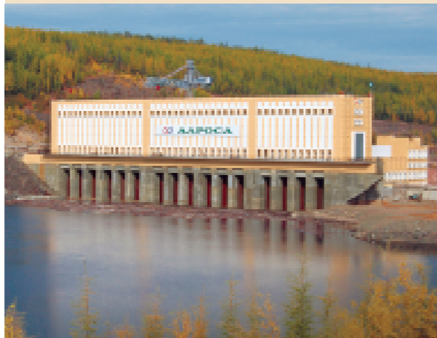
В декабре 2005 г. введен в эксплуатацию второй гидроагрегат Светлинской ГЭС
