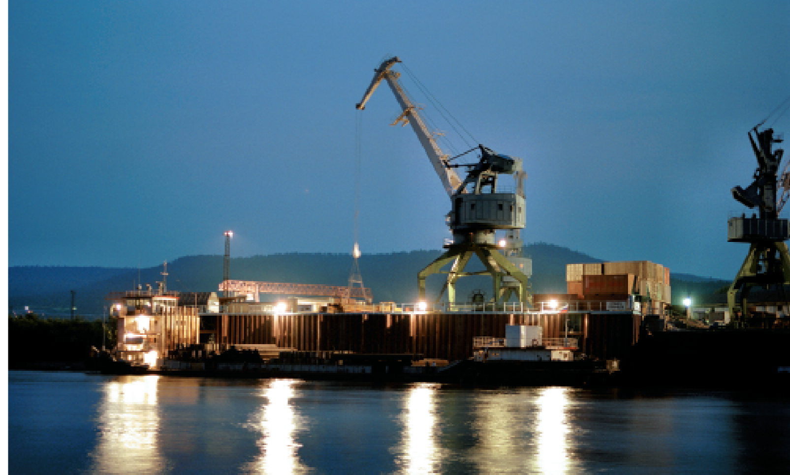
Навигационные работы в речном порту г. Ленска
