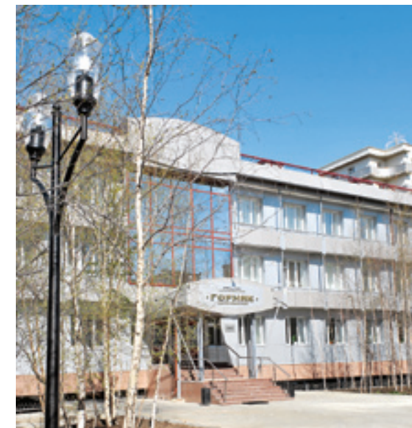
Санаторий-профилакторий «Горняк» после реконструкции
