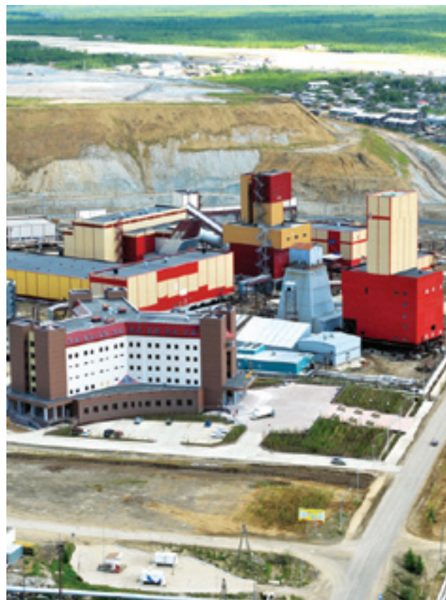
Строительство подземного рудника «Мир»
