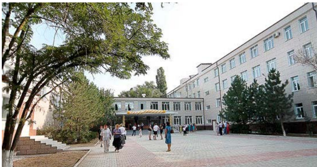
Средняя школа №3 Нефтекумск после капитального ремонта
