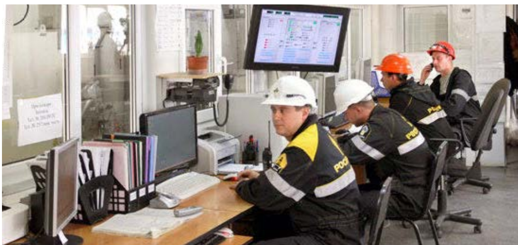
ГТЭС Хасырейского месторождения
