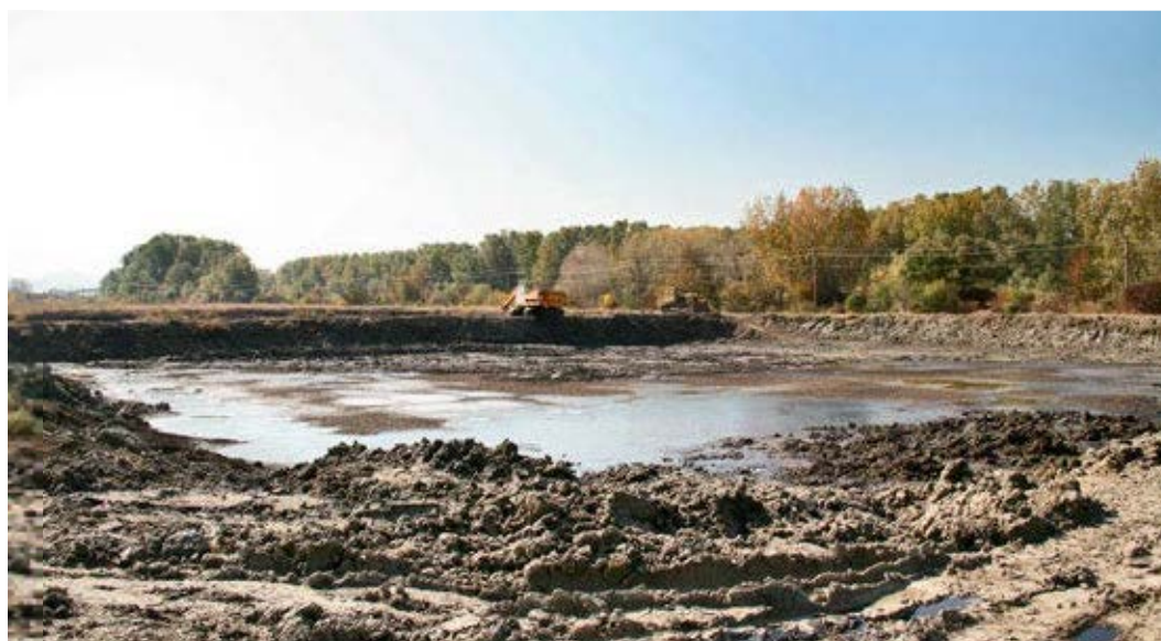
В «РН-Краснодарнефтегазе» проведены работы по подготовке нефтешламовых амбаров и прудов-отстойников пластовой воды для обезвреживания с последующей ликвидацией
