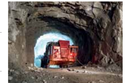
Подземные работы на Майском
