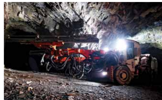
Подземные работы на Майском
