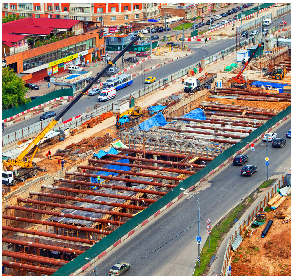
Строительство линии метро в районе станции «Раменки»
