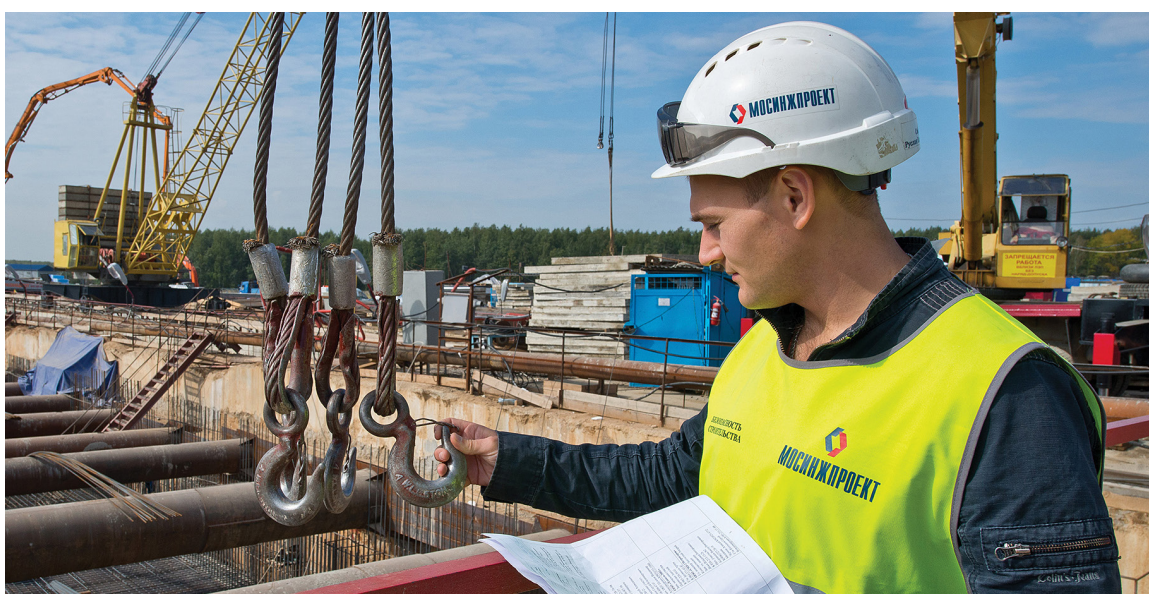
Строительный контроль на станции метро
