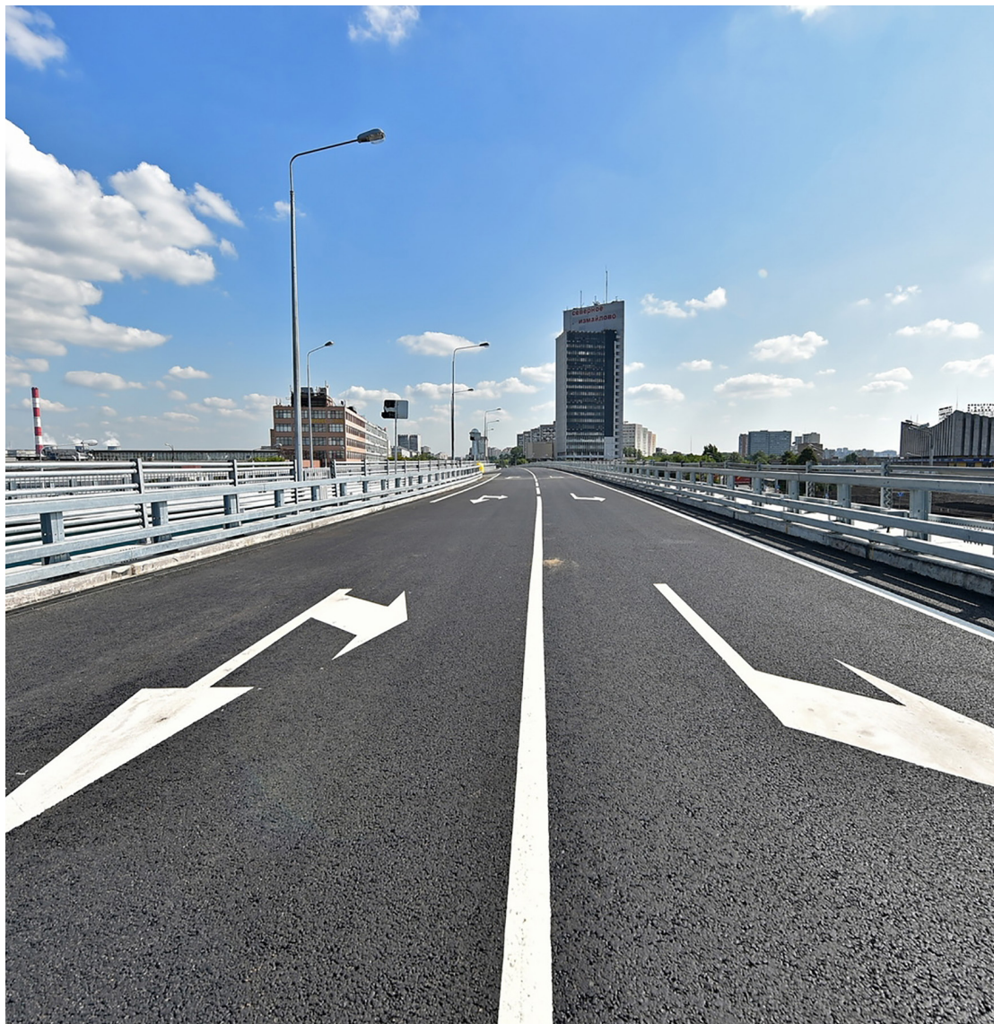
Эстакада на пересечении Щелковского шоссе и Северо-Восточной хорды
