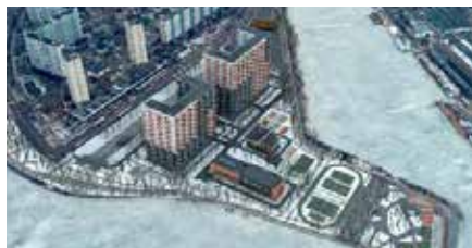
Жилой комплекс с торговой зоной и подземным паркингом в составе ТПУ «Нагатинский затон» общей площадью 33 636 м 2
