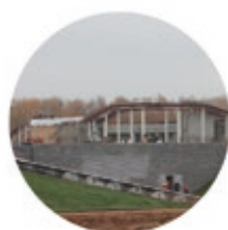
Электроснабжение ИЦ «Сколково»
