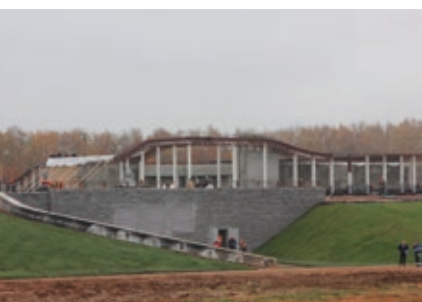
Внешний вид ПС «Сколково»
