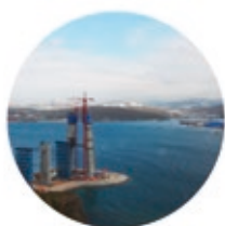
Электроснабжение саммита стран АТЭС
