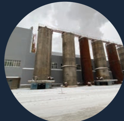
Здание отбельно-очистного участка БЦ ПСБЦ и ПБ Коряжма
