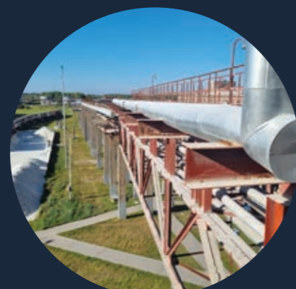
Новый коллектор пара 6 ата Усть-Илимск
