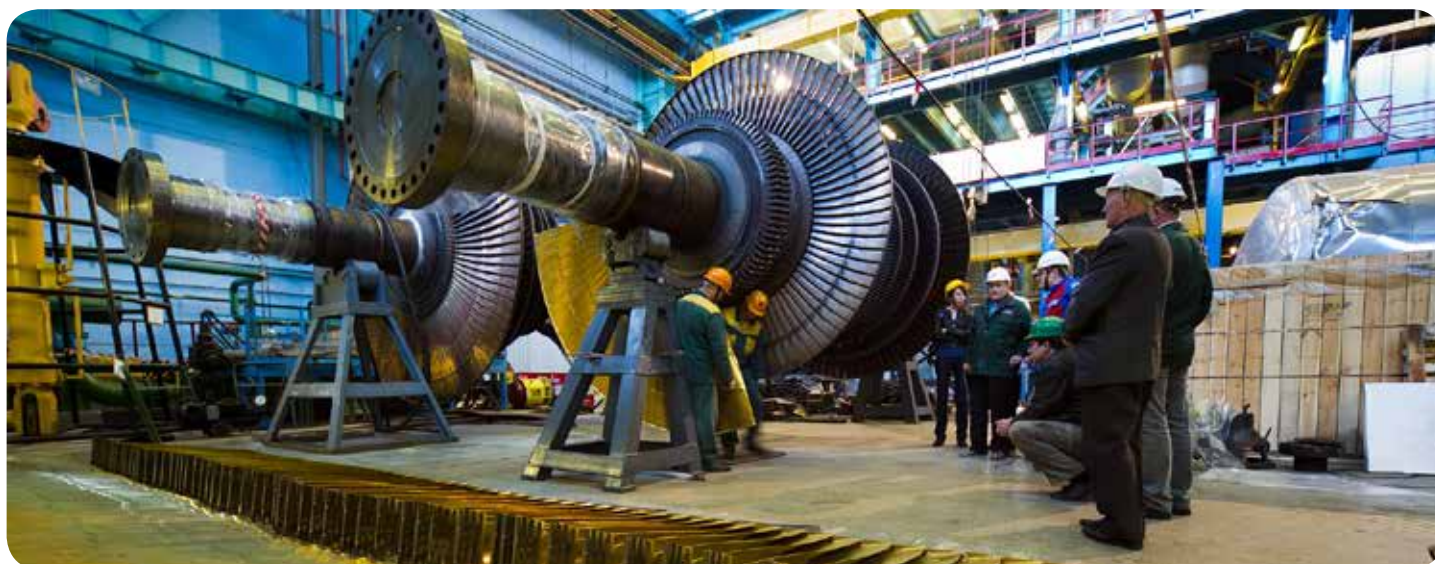
Монтаж турбины на АЭС
