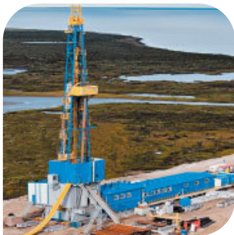
^ Буровая установка на Юрхаровском месторождении
