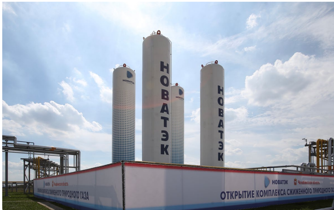
В 2020 году в промышленную эксплуатацию введен первый малотоннажный СПГ-завод в Челябинской области (Магнитогорск)
